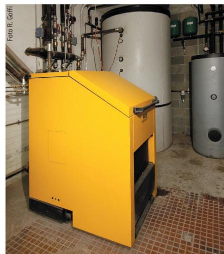
caldaia a pezzi di legno
