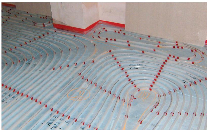
Nel caso dei condomini con riscaldamento centralizzato è possibile l'installazione di impianti a riscaldamento radiante con l'accorgimento fondamentale di installare un termoregolatore che consenta di abbassare la temperatura dell'acqua proveniente dall'impianto centralizzato prima che entri nel sistema di riscaldamento a pavimento.
